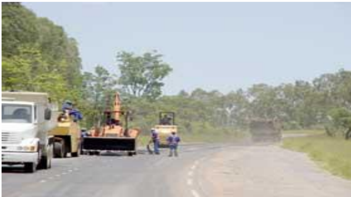
Figura 3 - Restauração da BR 354 –Entre o Município de Formiga/MG e Campo Belo/MG
