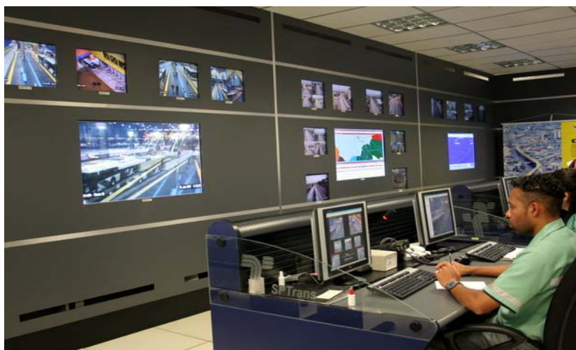
Figura 6 – Central de Monitoramento
