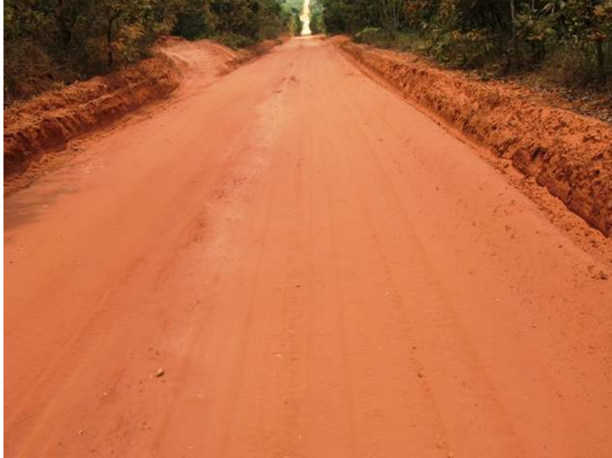
FIGURA1: Leito rebaixado FONTE: Autora (2011)
