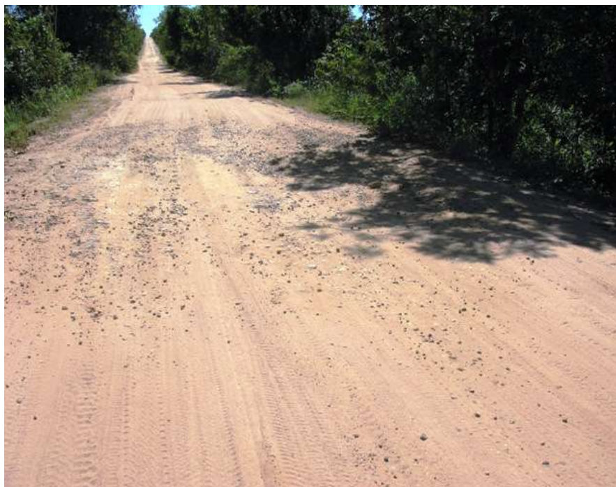
FIGURA 4: – Segregação de agregados Fonte: Autora (2010)
