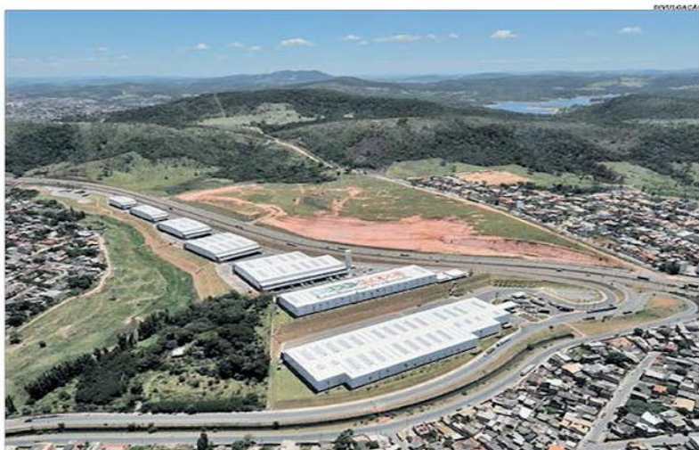
A Log Commercial Properties planeja investir R$ 1,5 bilhão até 2024 para ampliar a área locável
