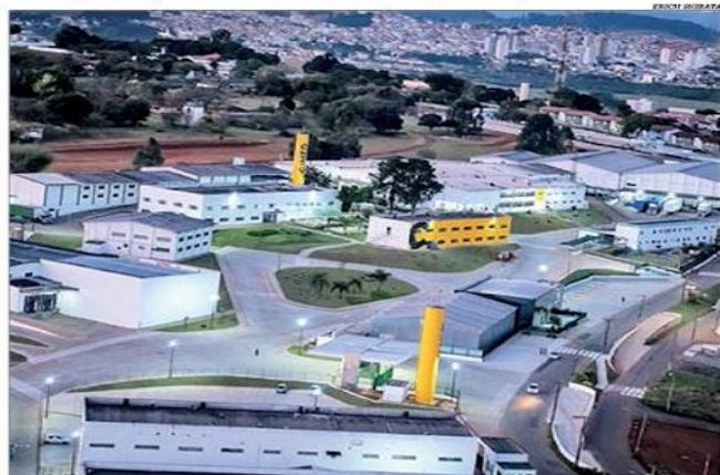
A capacidade produtiva da Cimed atingirá 40 milhões de comprimidos por mês
