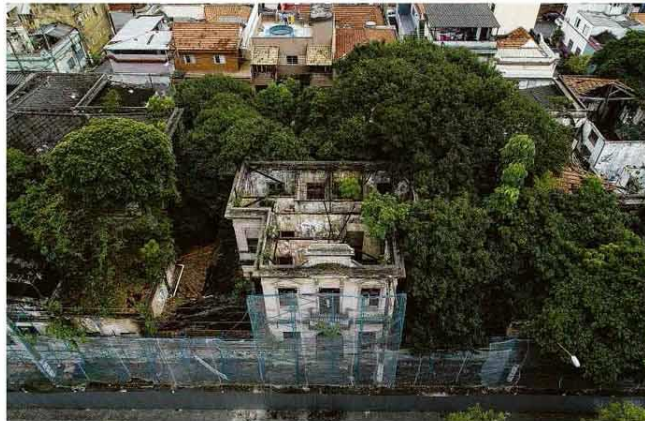
Edifício tombado na vila Maria Zélia, em São Paulo, um dos seis pertencentes ao governo federal no local. Eduardo Anzelli/Fotopress
