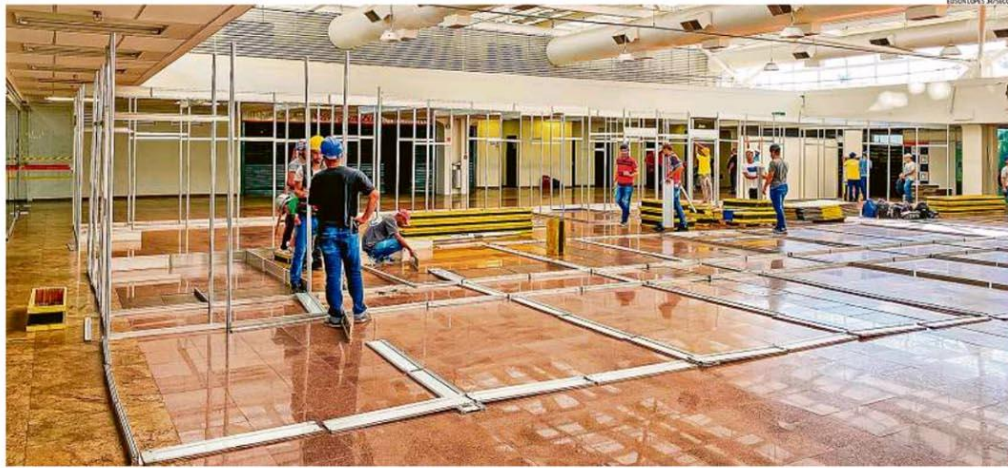
Obra em progresso. Operários trabalham na instalação de hospitais de campanha no Palácio das Convenções do Anhembi, Zona Norte da capital paulista, que terá 1.800 leitos. Outros 200 serão instalados no Estádio do Pacaembu
