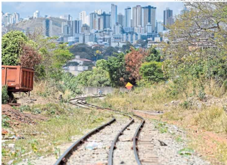
Obra do metrô de BH tem trechos abandonados, em deterioração
