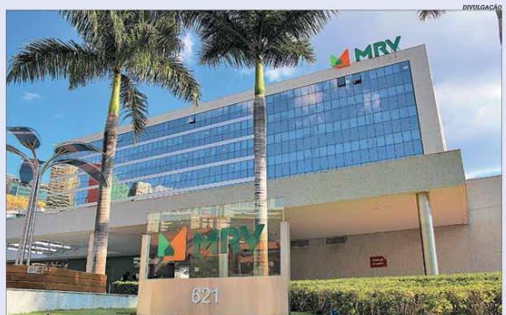
A MRV Engenharia lidera uma força-tarefa para comprar equipamentos hospitalares
