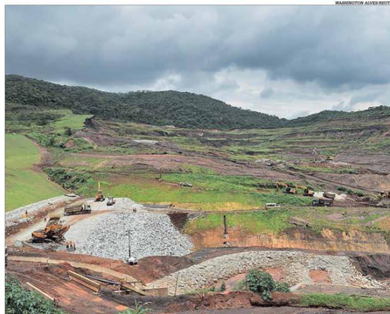
A dimensão dos danos causados pelo rompimento da barragem da Vale ainda está em avaliação
