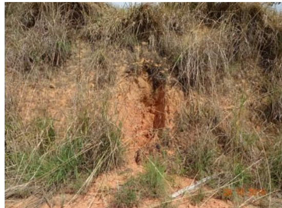
Figura 212 – Processo erosivo pontual.
