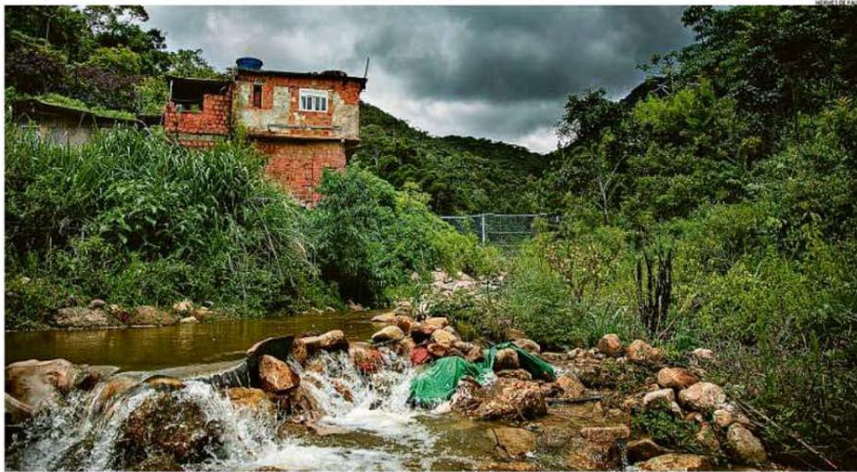
cenário da tragédia. Represa instalada no bairro da Posse, em Teresópolis, para tentar conter a força das águas. Ao fundo, construção em área de risco que veio a ser ocupada por moradores desabrigados
