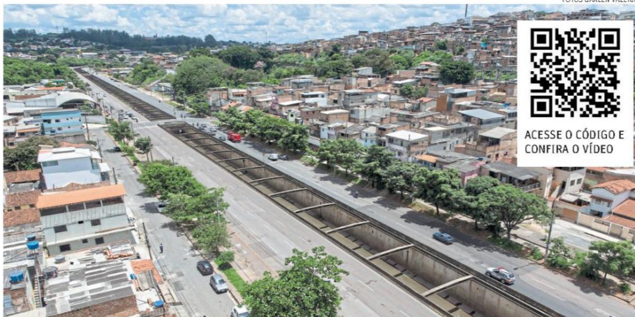
Rio Arrudas. Uma das principais vias da ligação entre Belo Horizonte e Contagem sofre há décadas com o problema dos alagamentos
