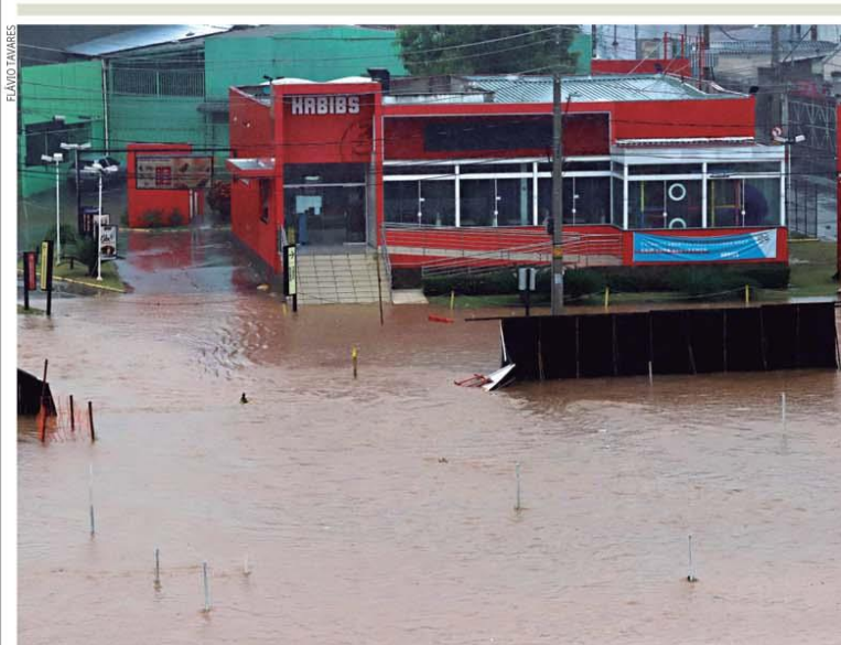
De novo. Avenida Vilarinho foi alagada por duas vezes ontem; prefeitura da capital informou que segue com obras na região
