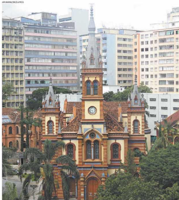
A Igreja São José, no Centro da capital, passa pela etapa final de uma restauração que já dura oito anos
